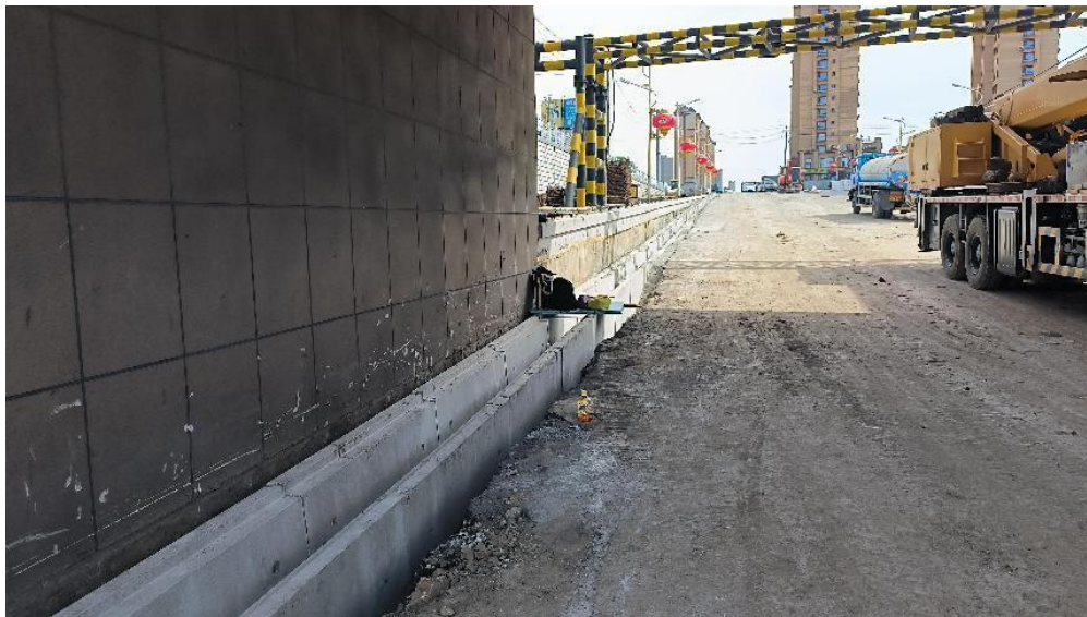
图 19 下穿立交主道排水沟建设
