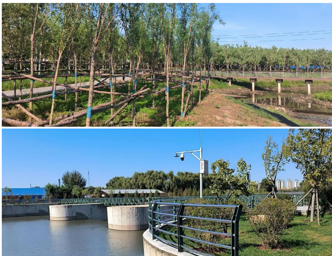
图 65 南河水环境项目生态驳岸和调蓄钢坝建设
