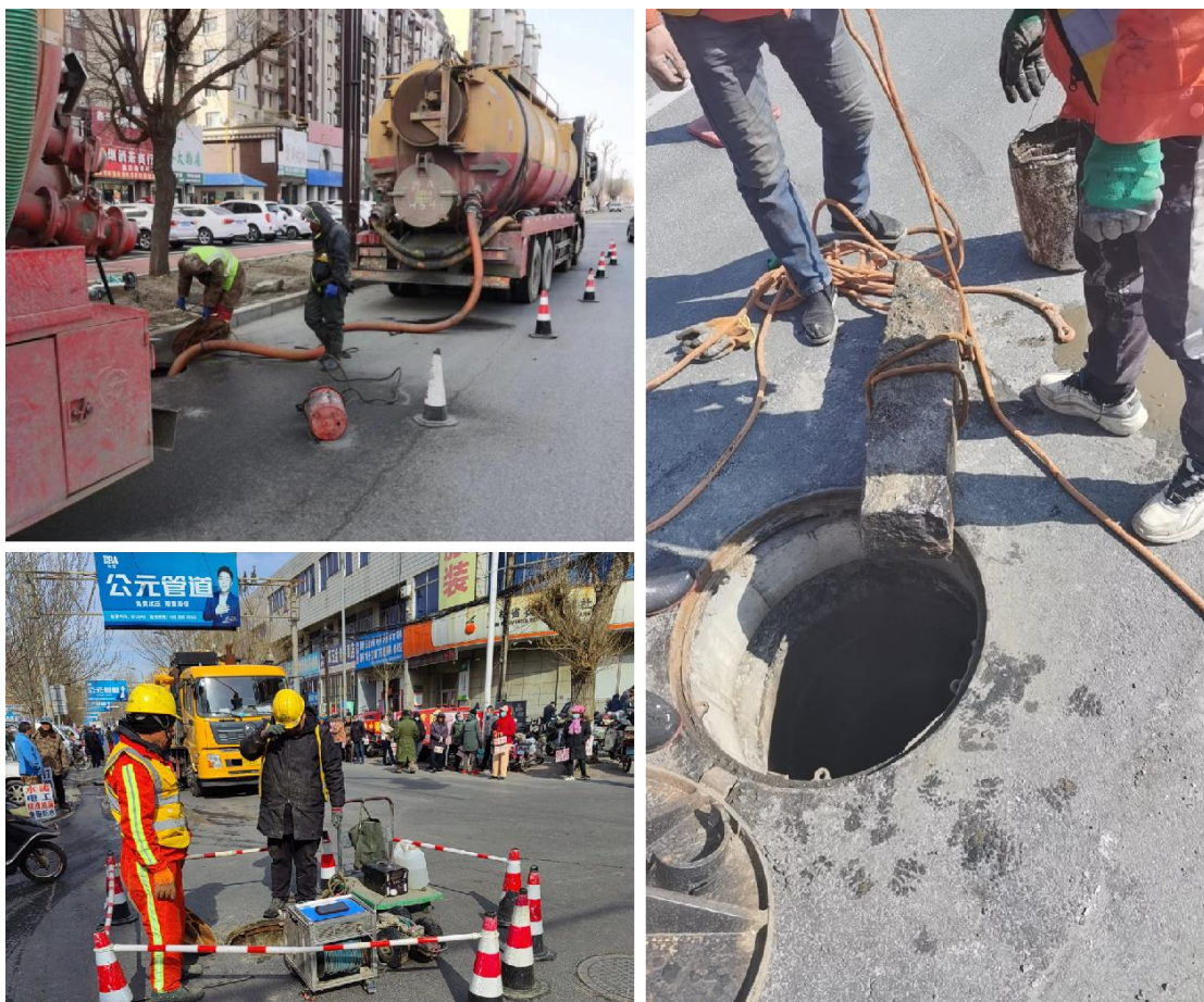
图 27 开展管道清淤现场
