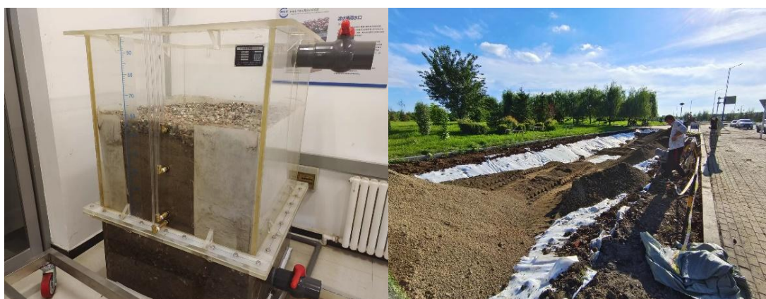
图 57 雨水花园再生骨料研发与换填
